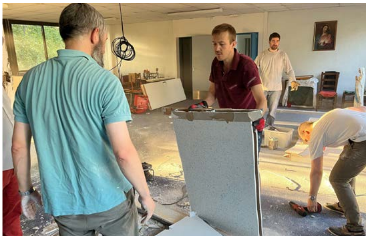
Les pères de familles prêtent main forte pour les travaux de rénovation
